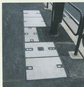
国道17号 群馬県前橋市上小出
