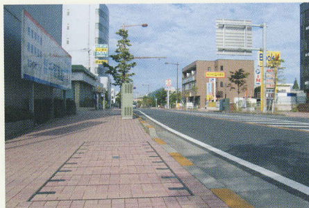
国道126号 千葉市都町 接続部
