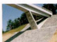
施工直後 橋梁周辺事例
