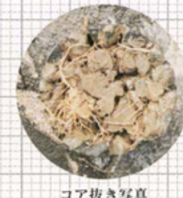
コア抜き写真
