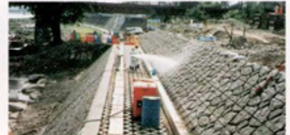
スティープC施工中
