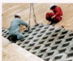
2. ブロック据付
