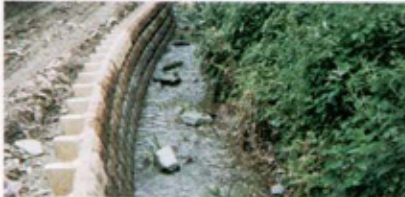
スティープY施工中
