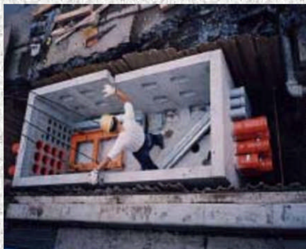
本体据付状況
