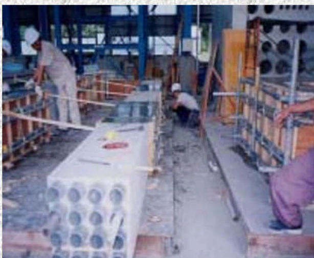
電纜管の製造
