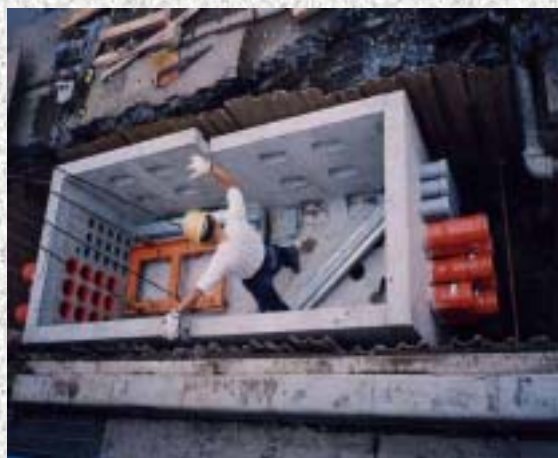
本体据付状況
