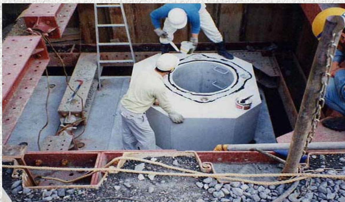
電力用マンホールの施工状況
