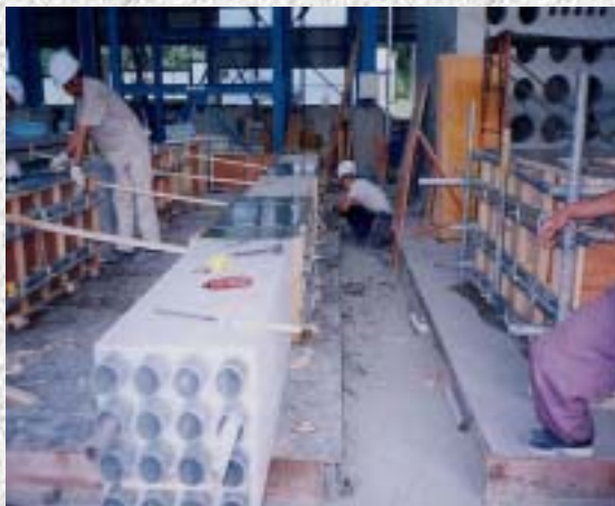
電纜管の製造
