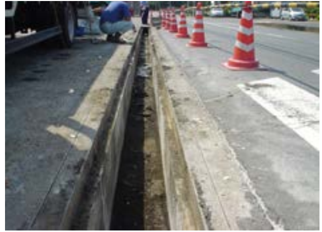
2 蓋撤去及びカッター処理
