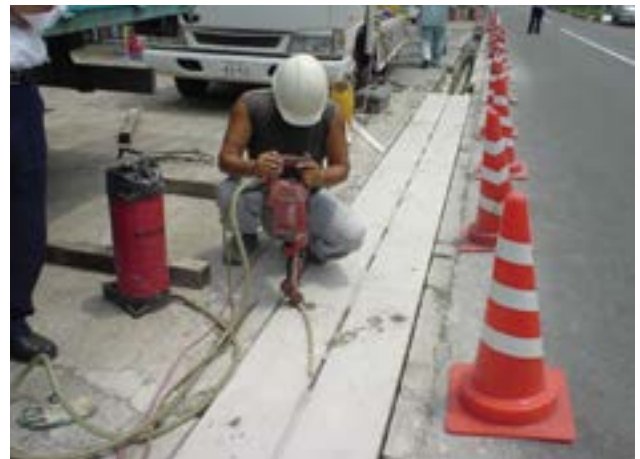
4 ズレ止め鉄筋用削孔
