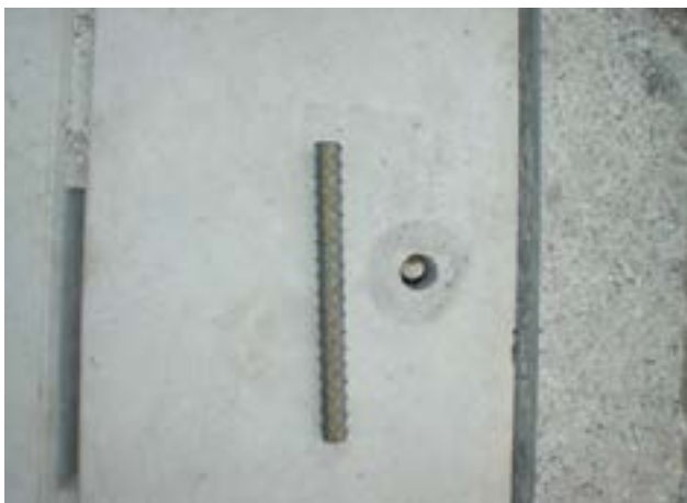
5 ズレ止め鉄筋挿入状況
