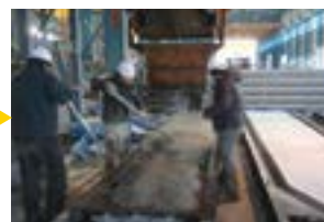
3 コンクリート打設
