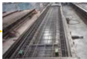
2 鉄筋籠設置
