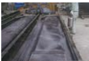
1 型枠（雛型剤塗布）
