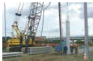
コンクリート矢板建込み
