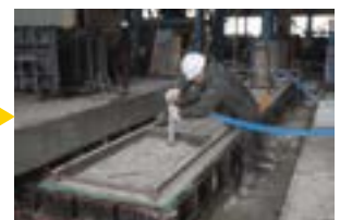
4 真空マットフレーム設置
