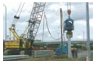
コンクリート矢板打込み
