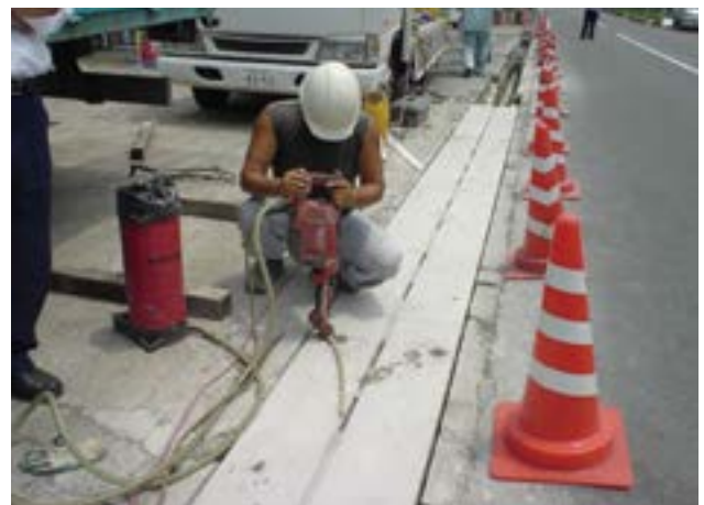
4ズレ止め鉄筋用削孔
