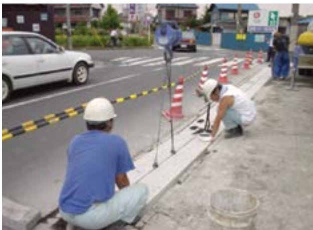
3 BFB スリット設置
