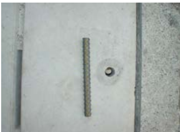
5ズレ止め鉄筋挿入状況
