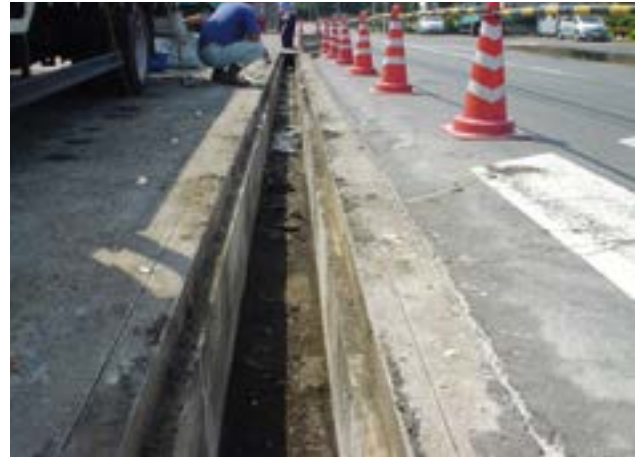
2 蓋撤去及びカッター処理
