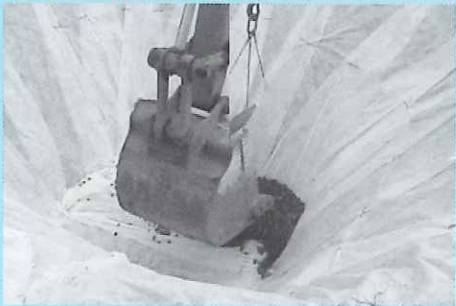
④浸透用底版の据付け
