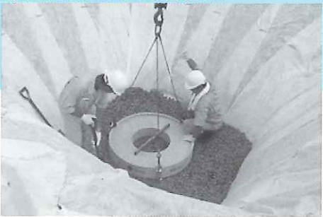
④浸透用底版の据付け
