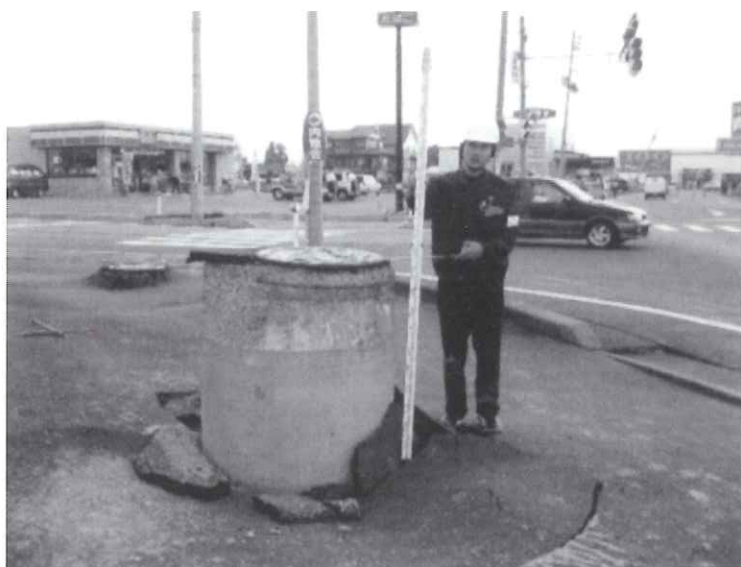
平成16年10月 新潟県中越地震の状況(小千谷市)
